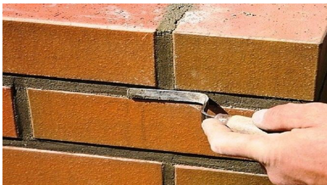
Рис.1 Шов в кирпичной кладке
