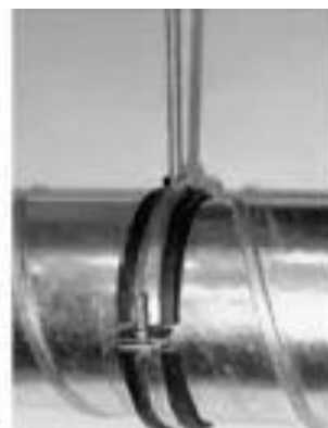
Крепление при помощи хомута и шпильки
