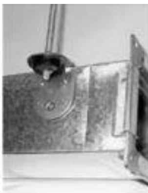
Крепление при помощи L-образного профиля и шпильки
