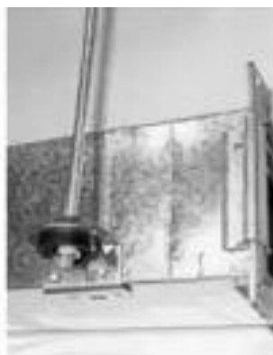
Крепление при помощи Z-образного профиля и шпильки
