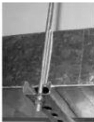
Крепление при помощи траверса и шпильки
